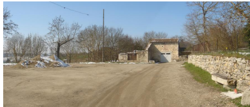
Marge de l'église à qualifier
