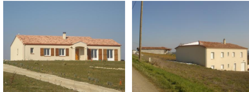
Constructions pavillonnaires présentant des caractéristiques architecturales distinctes, tant au niveau des volumétries, du traitement des ouvertures ainsi que du degré et du nombre de pentes des toitures, secteur de Saint-Gény
