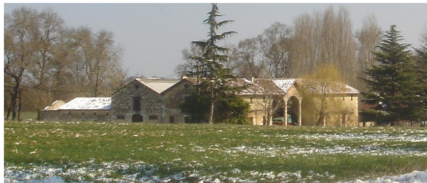
Bâti traditionnel de belle facture, La Rivière
