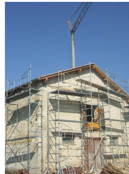
Réhabilitation en cours, secteur Lamalesse
