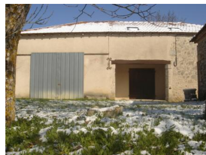
Intervention sur l'existant : traitement des ouvertures et traitement de la façade sur une unité de stockage ; rafraichissement des façades par la pose d'un enduit et l'utilisation de badigeon sur une habitation en marge de l'Eglise.
