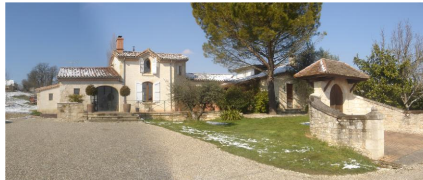
Construction contemporaine établie en marge de la mairie reprenant pour partie les caractéristiques architecturales traditionnelles : murs en pierre apparente, présence de génoises, large ouverture, etc.
