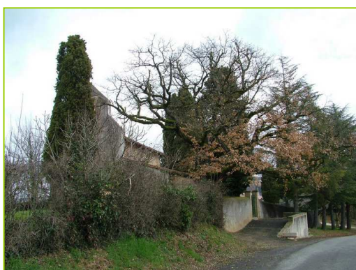
Photo 25 : Façade Sud-Ouest de l'Eglise.
