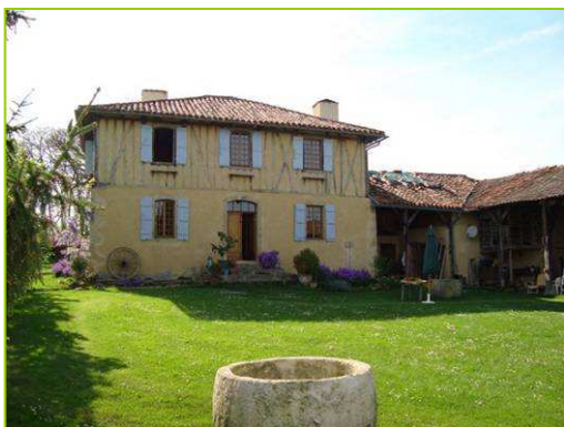
Photo 12 : Façade d'habitation à l'est avec amorce des annexes.
