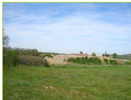
Photo 6 : Maison récente en maçonnerie traditionnelle.
