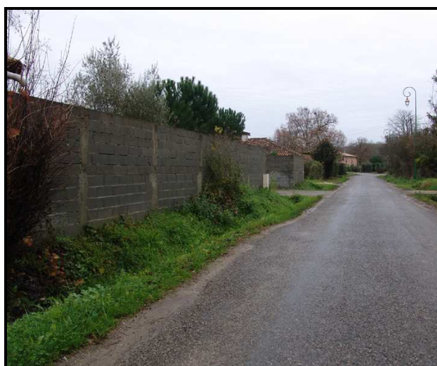
Un mur de clôture très dommageable
