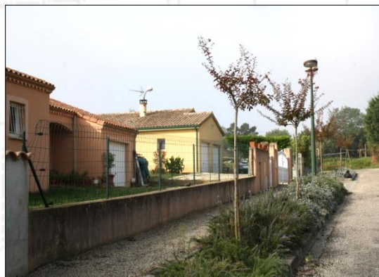
Extensions sous forme de lotissement (rue de la Sagesse)
