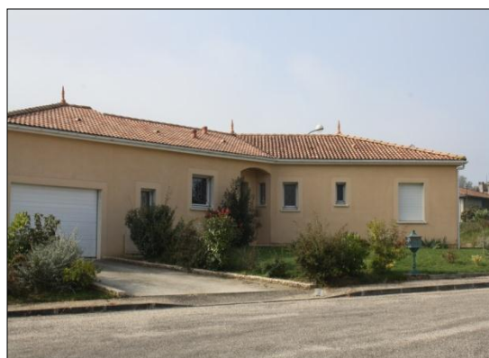
Les façades ont des couleurs claires (rue de la Beauté)
