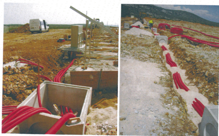
illustrations des tranchées mise en place (source : Soleil du Midi)
