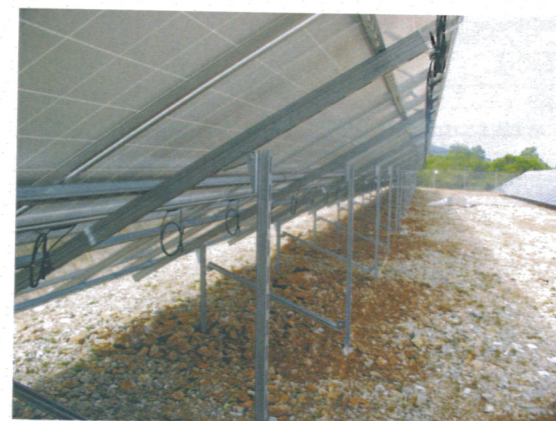
Illustration d'une structure en cours de montage (Soleil du Midi, 2010)
