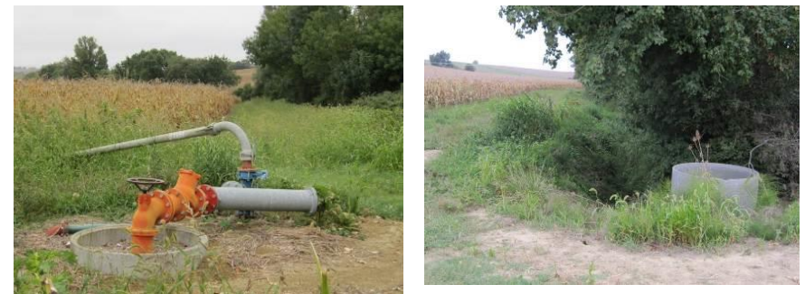
Installations sur le ruisseau de Noailles
