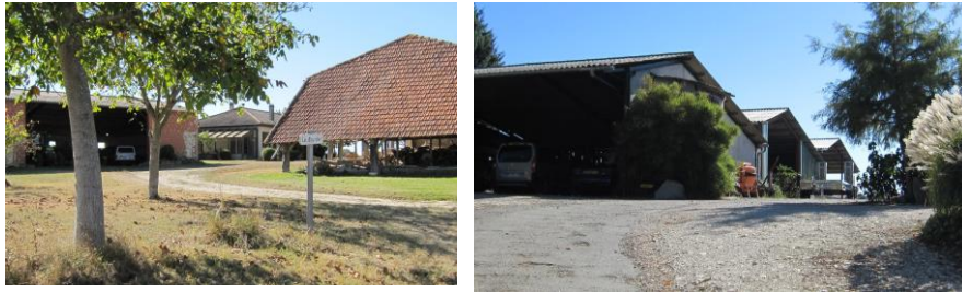
Illustrations photographiques de bâtiments agricoles sur Monbrun
