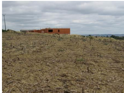
Construction neuve en ligne de crête
