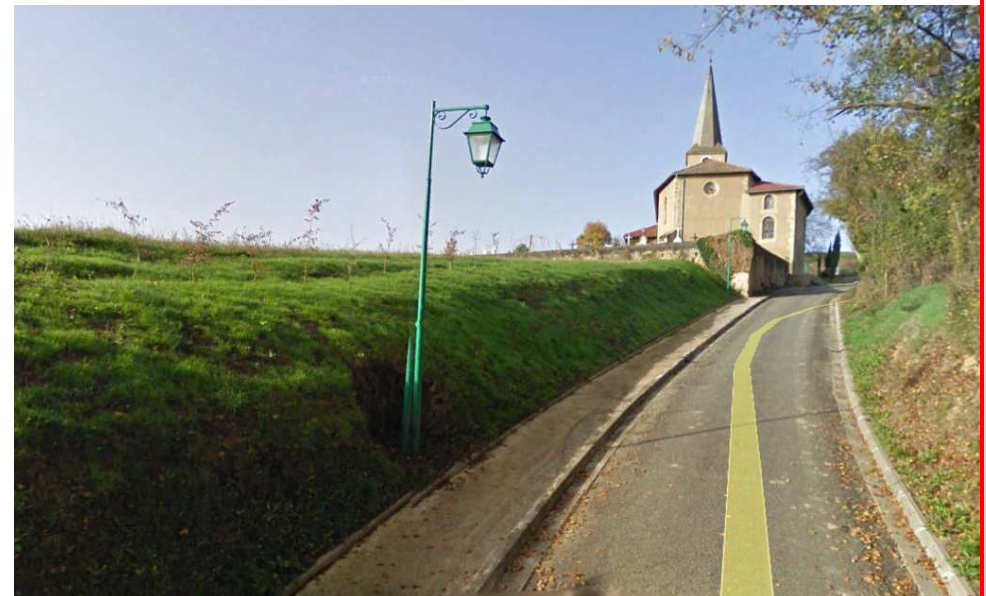
Le talus le long du chemin de Crète.
