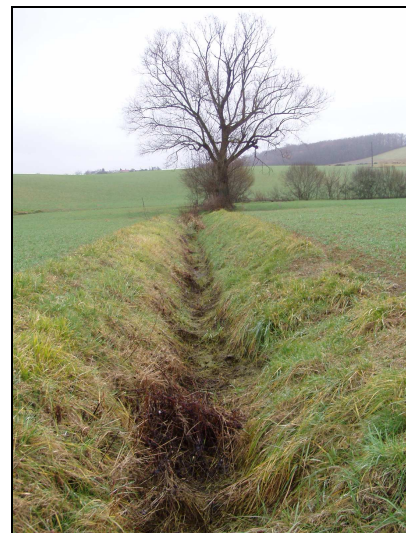
Fossé ouest avant rejet dans l'Auzoue
