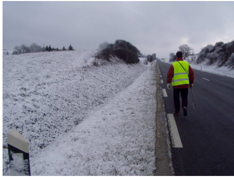
Séquence en surplomb de la route présentant une haie buissonnante discontinue
