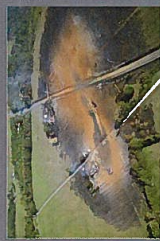
Conséquences d'une fuite sur une canalisation de transport Appalachia (USA), 14 septembre 2008 (source istockphoto ).
