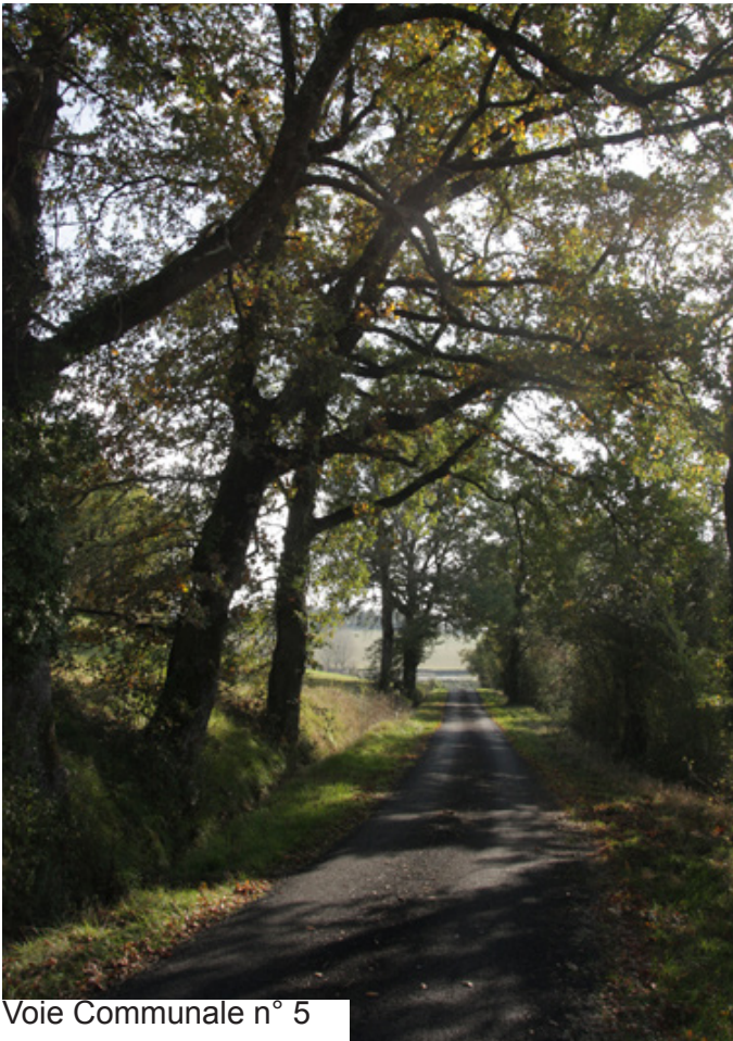
Route départementale 259 dans le village
