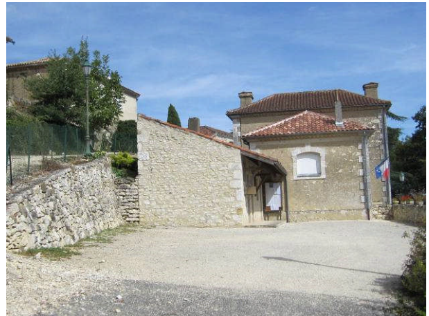
La mairie sur le mur d'enceinte
