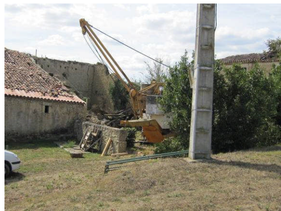
Réhabilitation de bâti ancien
