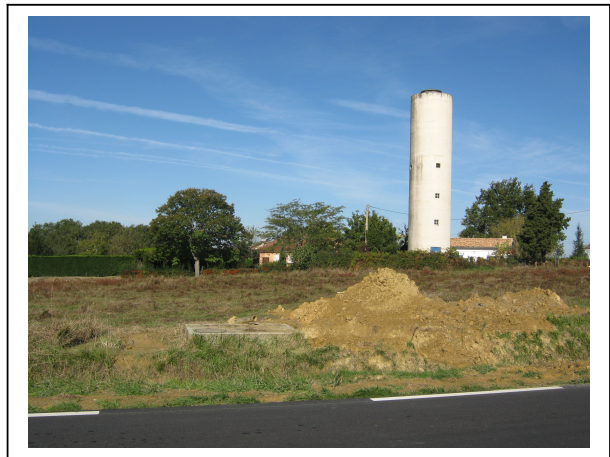
Le château d'eau
