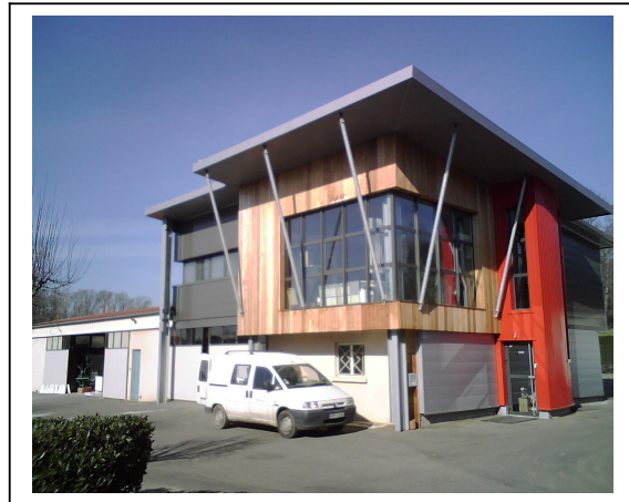
Entreprise de bâtiment
