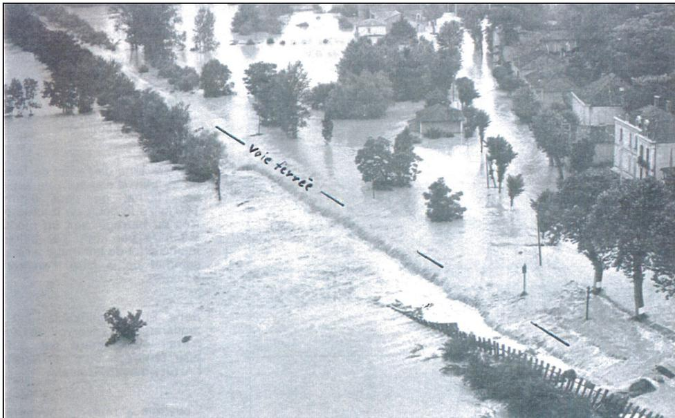
Figure n° 4 : Vue aérienne de la crue du 8/07/1977 à Montestruc - A cet endroit, la voie ferrée traverse la vallée du Gers en remblai. Le remblai est submergé et la photo met en évidence le rehaussement de la ligne d'eau (surcote) qu'il provoque côté amont.
