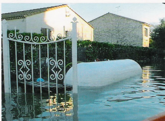
Cuve soulevée par l'eau.
