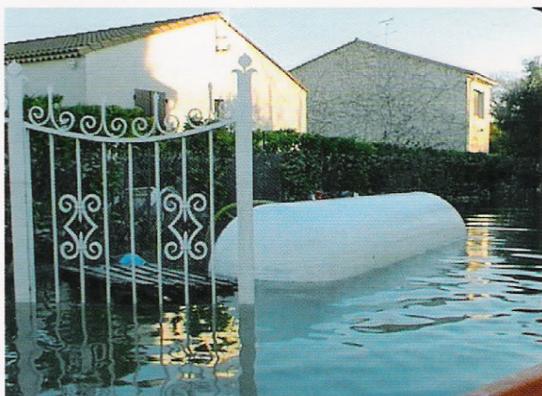
Cuve soulevée par l'eau.
