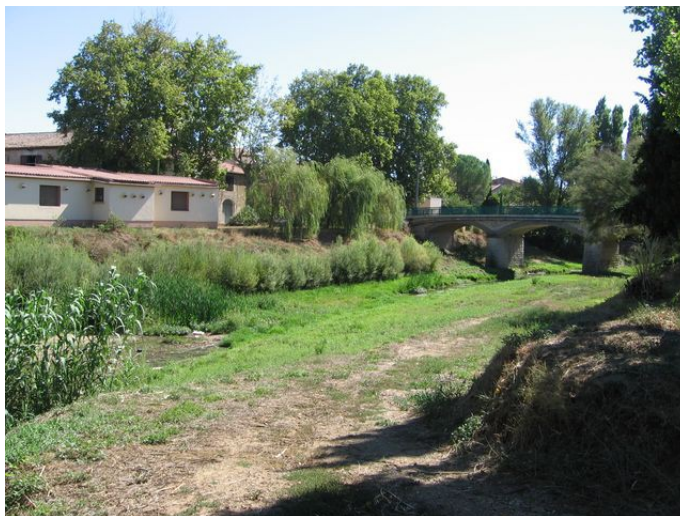
Pont de Lieuran-les-Béziers et enjeux localisés en rive gauche
