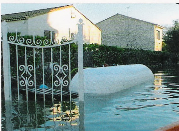
Cuve soulevée par l'eau.
