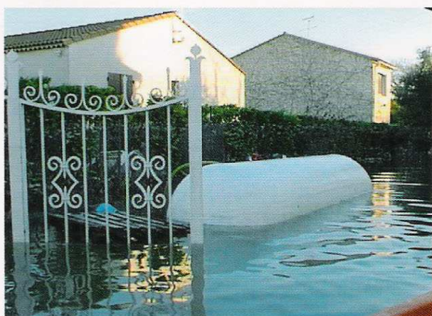
Cuve soulevée par l'eau.
