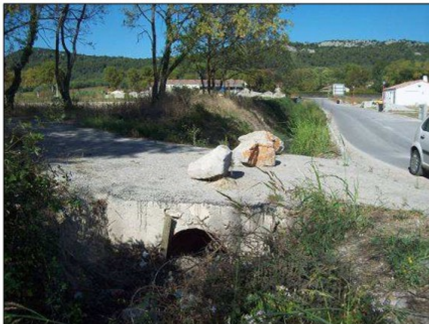
Fossé pluvial à proximité du nouveau lotissement
