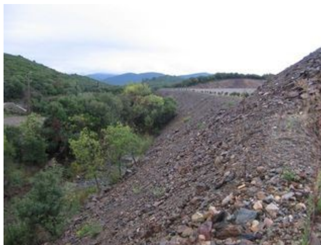
Remblai en rive du Gournautuc limitant les débordements
