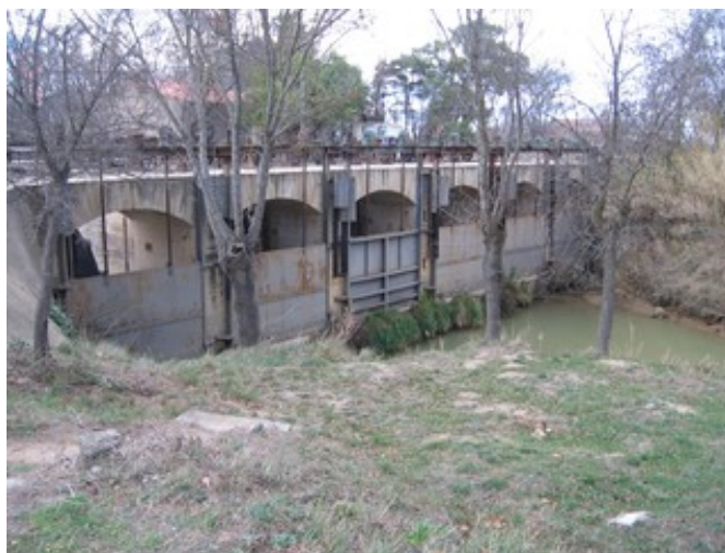
Ouvrage pour la traversée du Canal du Midi
