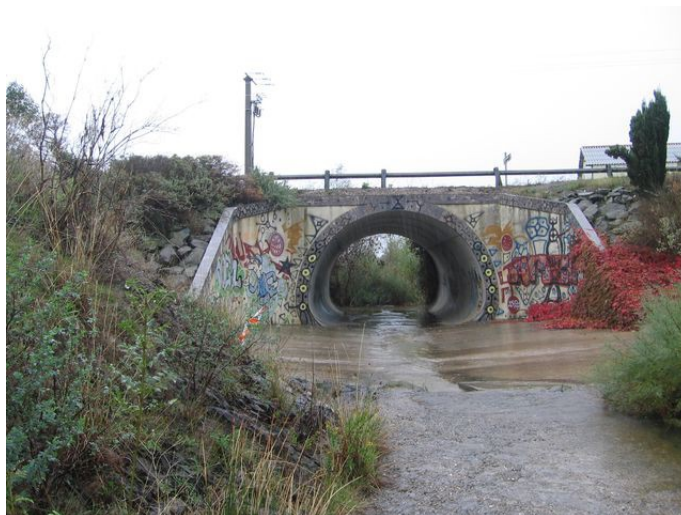
Ouvrage hydraulique et remblai d'infrastructure sur le Gournautuc
