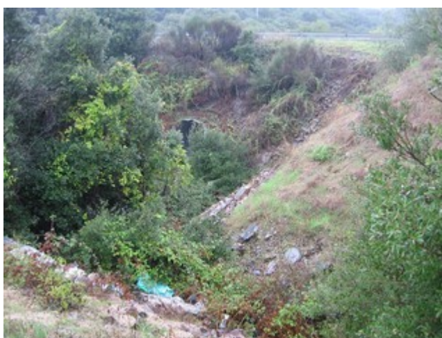
Zone remblayée perturbant les écoulements du ruisseau
