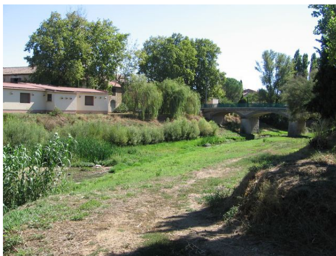
Pont de Lieuran-les-Béziers et enjeux localisés en rive gauche
