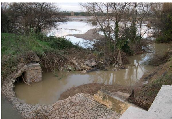
*Dégâts sur une digue (Mosson - 12/2003 - photo DDTM)*
