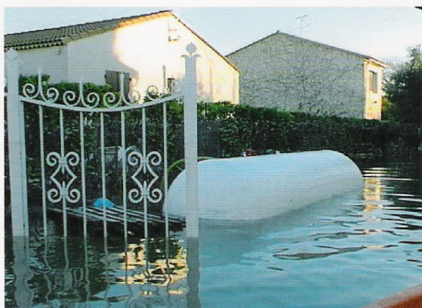
Cuve soulevée par l'eau.
