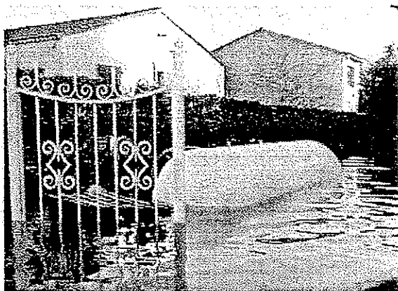
Cuve soulevée par l'eau.
