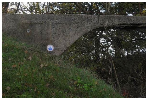
Le repère de crue de 2005 sur l'Ardaillou
