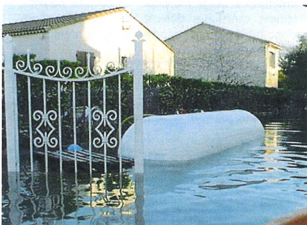
Cuve soulevée par l'eau.
