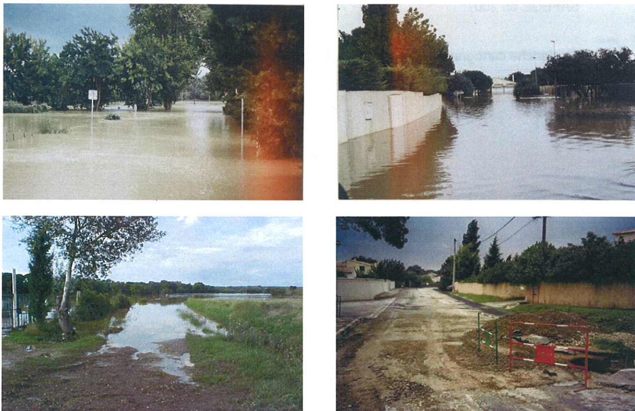
Figure 6 : Déroutement de crue et dégâts sur voiries.
