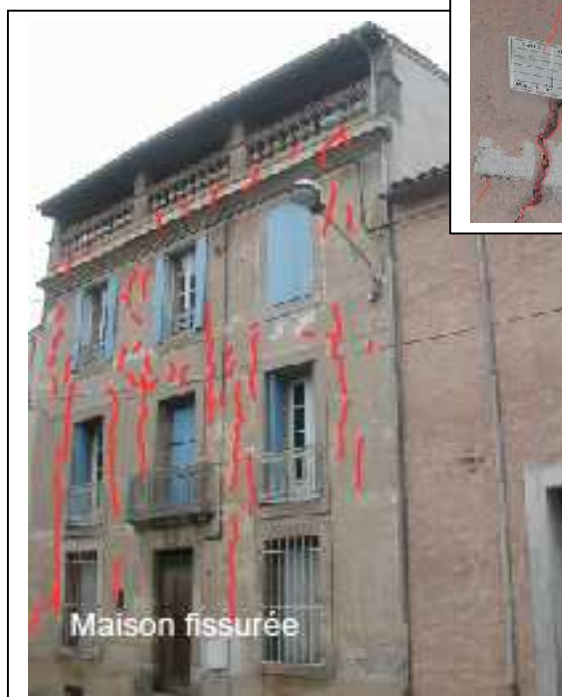
Figure 38 : Exemple de désordres probablement associé au phénomène de retrait/gonflement des argiles (Alluvions quaternaire : commune de Lodève).
