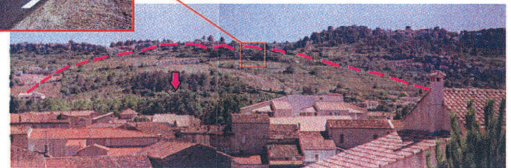
Fig. 25 : Glissements affectant la RD20 entre Saint-Chinian et le Moulin
