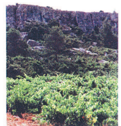
Fig. 29 : Eboulement au Pied du tènement de la Rouquette au dessous du point 240.
