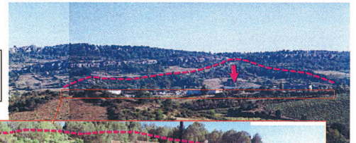
Fig. 24 : Glissement de versant au lieu dit « Le Martinet » le long de la RN112
