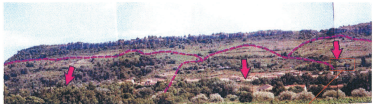
Fig. 23 : Ensemble de glissements emboîtés le long de la RN112 entre Fontjun et l'entrée de Saint-Chinian
