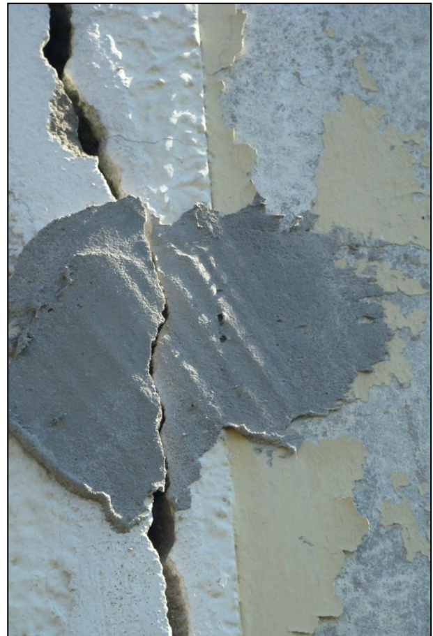
Figure 67 : Témoins fissurés sur la construction impactée par les fontis du 6 juillet 2012 [Source : IMS RN ]
