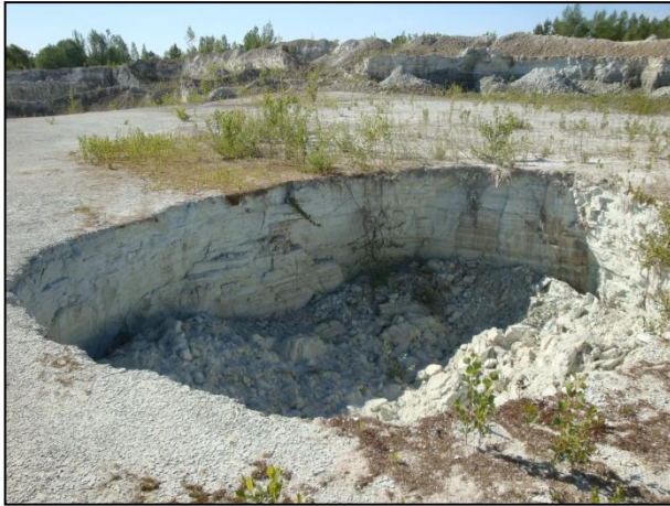
Figure 39 : Effondrements présents sur le site SOCODAC en Juin 2012 (désordre n° 1 sur la photo de gauche et désordre n° 6 sur celle de droite) [Source : BRGM]
