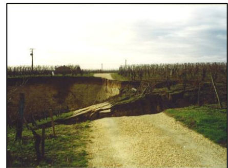
Figure 49 : Schéma [Source : BRGM] et photographie d'un effondrement généralisé à ST-EMILION (Gironde) [Source : CG 33]
