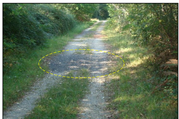
Figure 65 : Zone remblayée sur un chemin à l'Est de SOCODAC [Source : IMS RM ]
