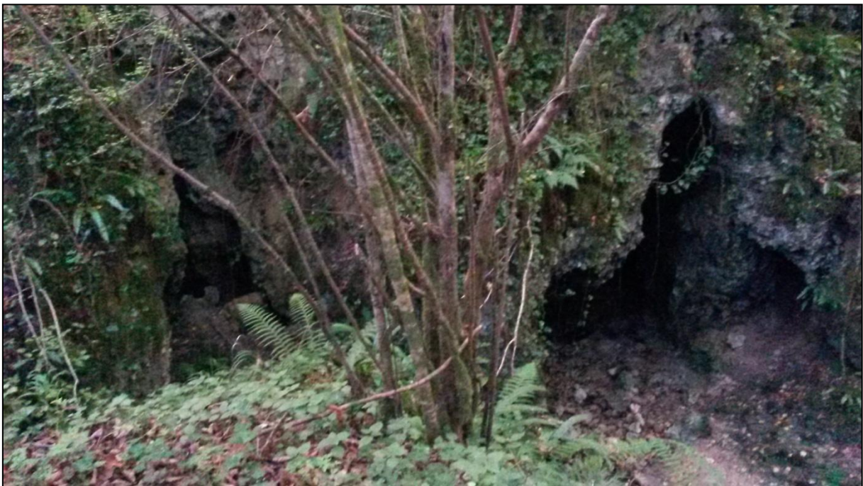
Figure 69 : Cavités pyramidales dans le talweg du ruisseau du Cros [Source : IMS RN ]
