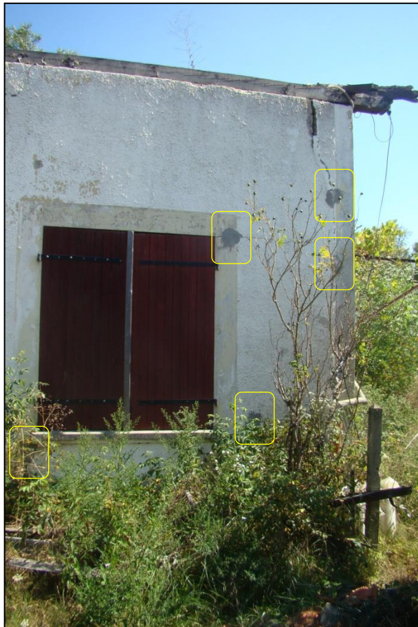
Figure 67 : Témoins fissurés sur la construction impactée par les fontis du 6 juillet 2012 [Source : IMS RN ]
