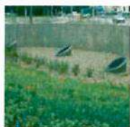
Puits d'infiltration aval associé à un bassin de rétention, Beynost
