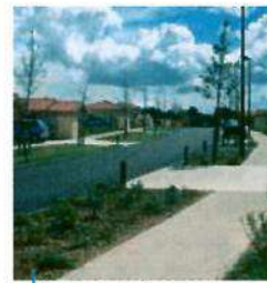
Noes engazonnées en zone pavillonnaire, Villefontaine
