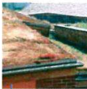
Toitures végétalisées, lycée Jacquard, Caudry
