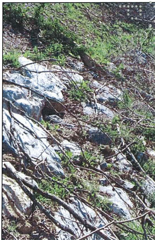
Figure n°8: enrochement en pied de remblai
