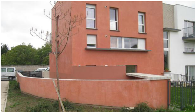
Un parking souterrain indépendant
