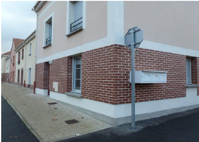
Mise en retrait symbolique de l'espace privé par une simple différenciation de traitement de sol
