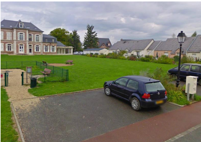
Stationnements aériens sobrement délimités pour les visiteurs
