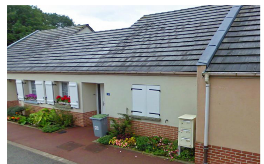
Des limites sans dénivelés jouant sur le fleurissement des entrées
