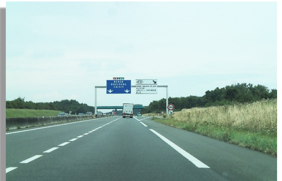
Échangeur autoroutier A16
