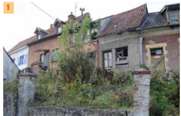
1 Logements dégradés à Frévent
