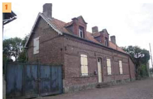
1 Ancien logement potentiellement peu performant sur le plan thermique
