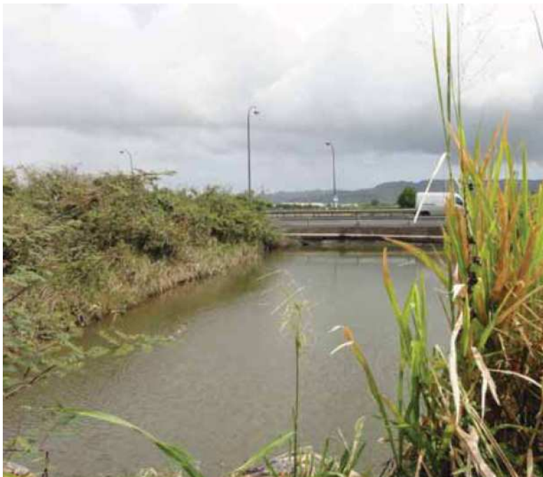
Figure 4 : Autoroute A1 à proximité de la rivière Lézarde – commune du Lamentin (source : CETE Méditerranée, EPRI 2011)
