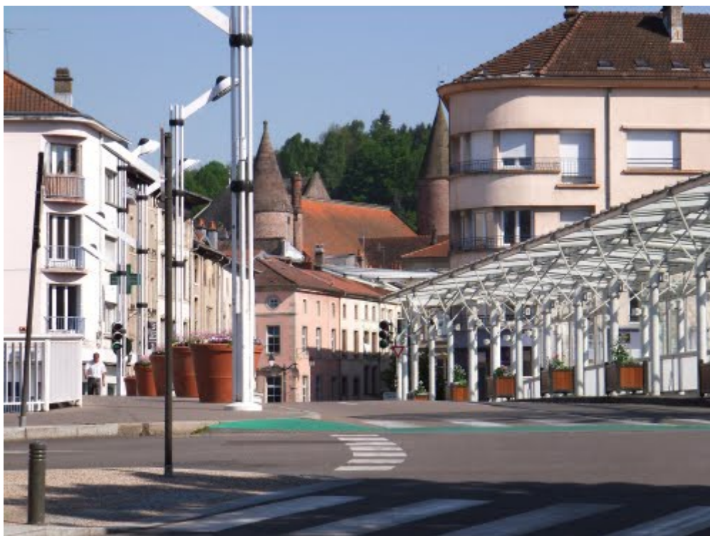
Illustration 4: Épinal, le Pont du 170e R.I. de nos jours, avec la passerelle couverte en face amont.
