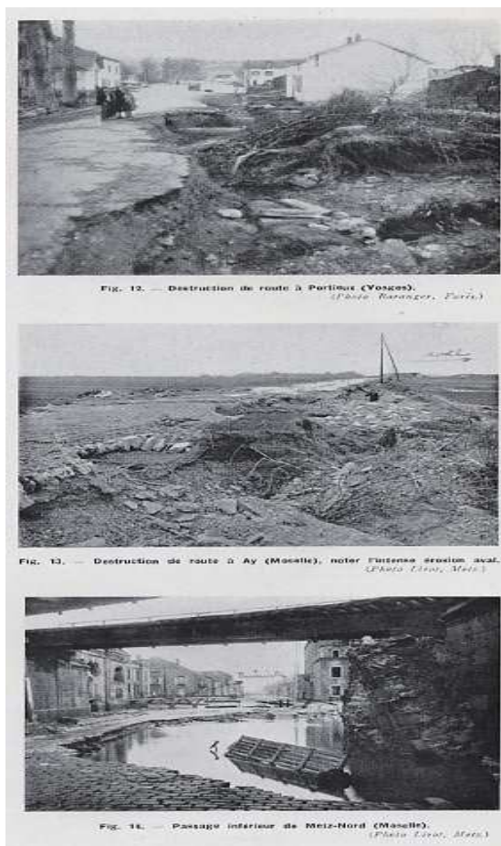
Destruction de route à Ay et passage à Metz Nord
