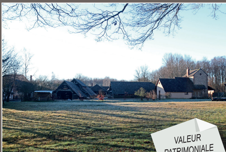
Vue générale des bâtiments de la tuilerie (Ph. J. Patureau)
