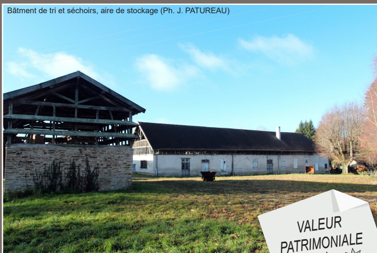
Bâtiment de tri et séchoirs, aire de stockage (Ph. J. PATUREAU)
