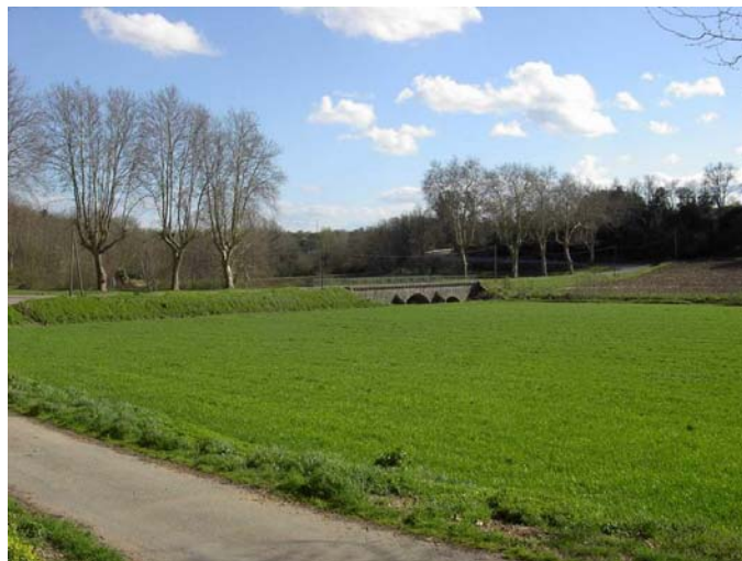
Photo 5 : Remblai barrant la plaine alluviale
