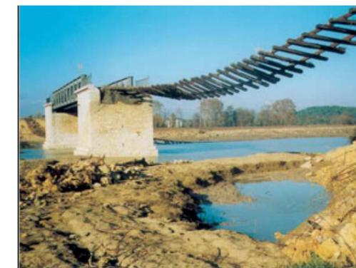
Photo 18 : Du côté de Sallèles... La voie ferrée emportée par les eaux - Crue du 12 au 14 nov 1999
