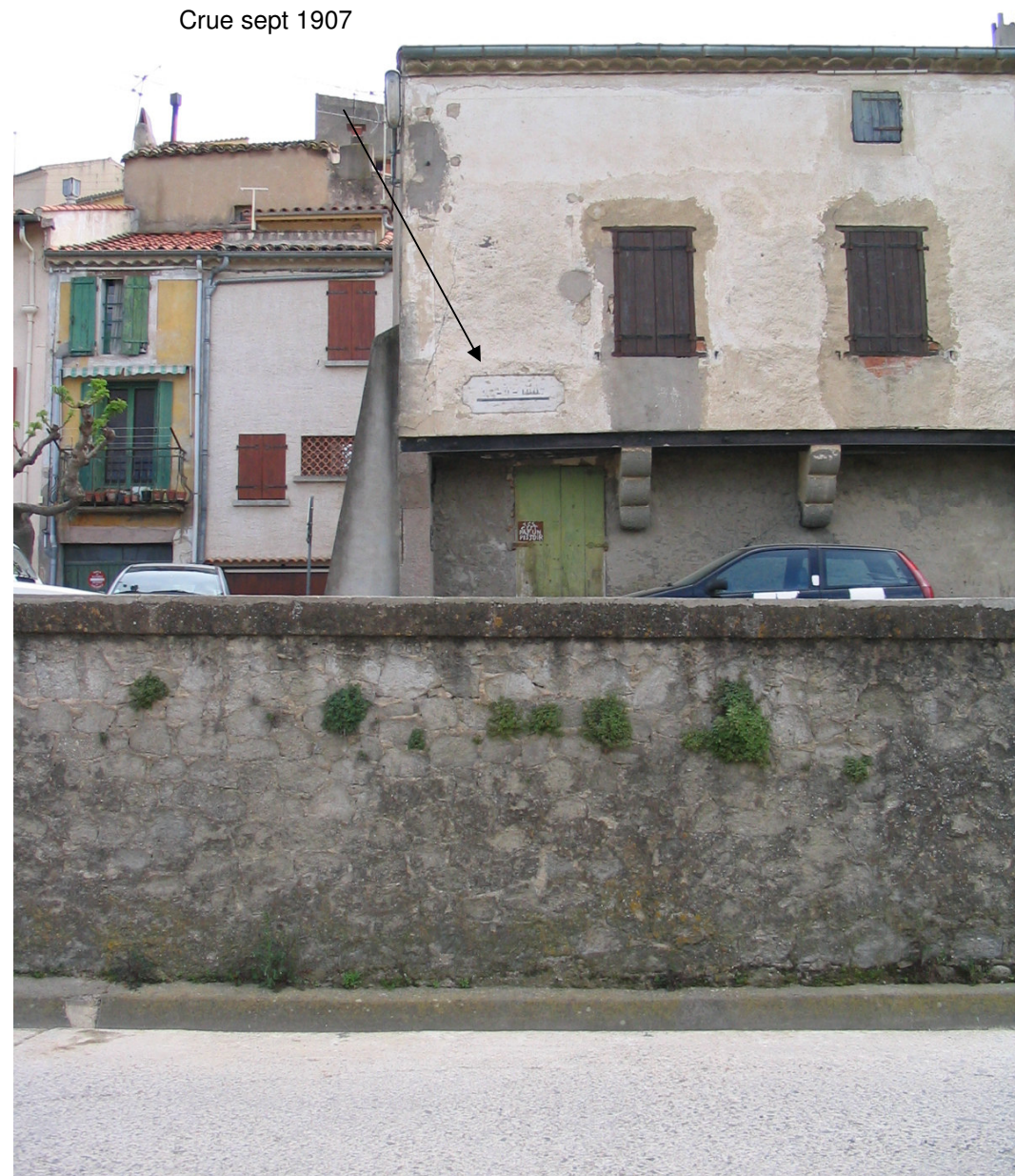
Photo 13 : Repère de crue dans le village
