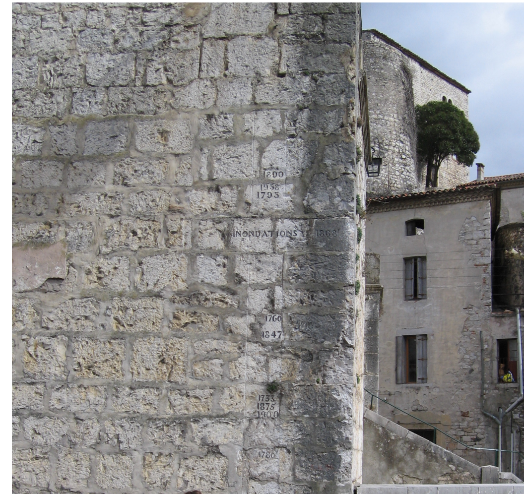
Photo 2 : Repère de crue sur l'église de Laroque.
