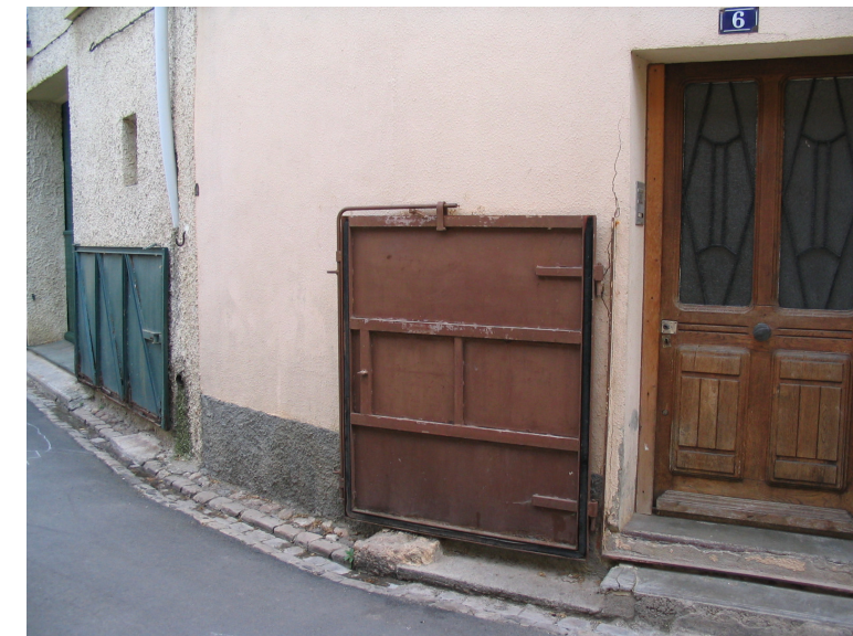
Photo 12 : Batardeau dans le village
