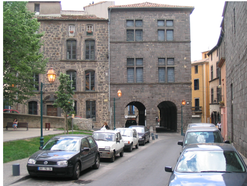
Photo 14 : Construction en arches adaptée aux débordements en Agde
