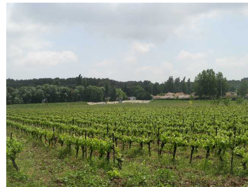
Photographie 15 : Maisons en zone inondable "protégées" par le bassin de rétention
