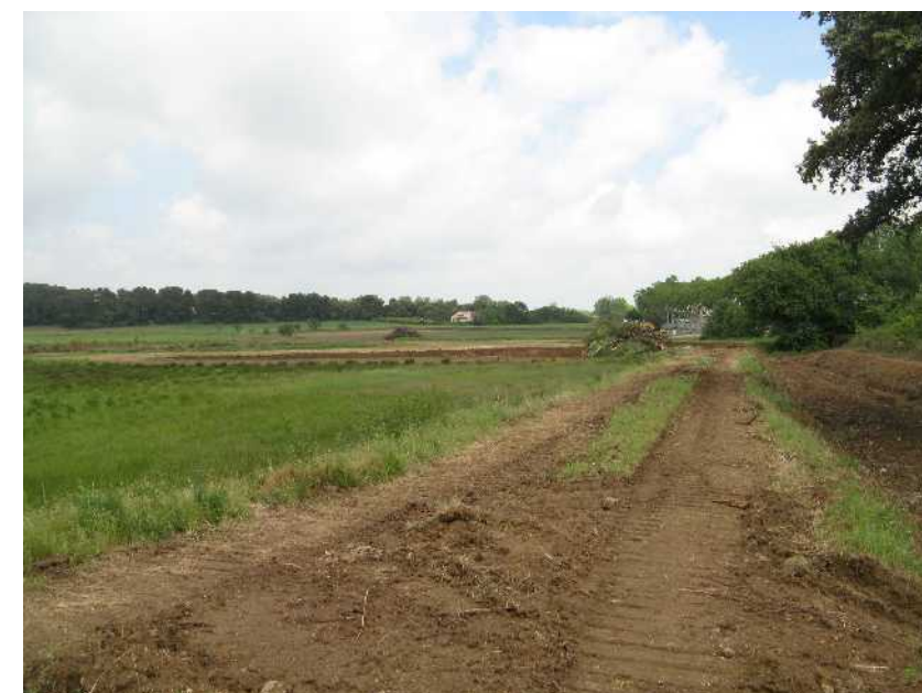
Photographie 14 : Bassin en cours de réalisation
