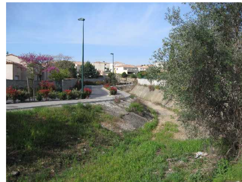
Photographie 39 : Chenalisation de la Billière ; zone de débordement possible en rive gauche
