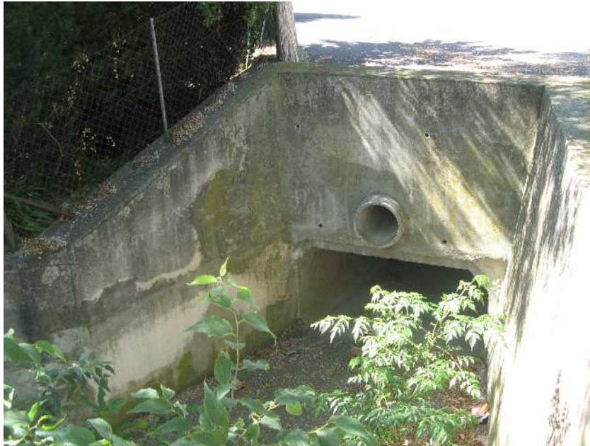
Photographie 29 : Ouvrage limitant
