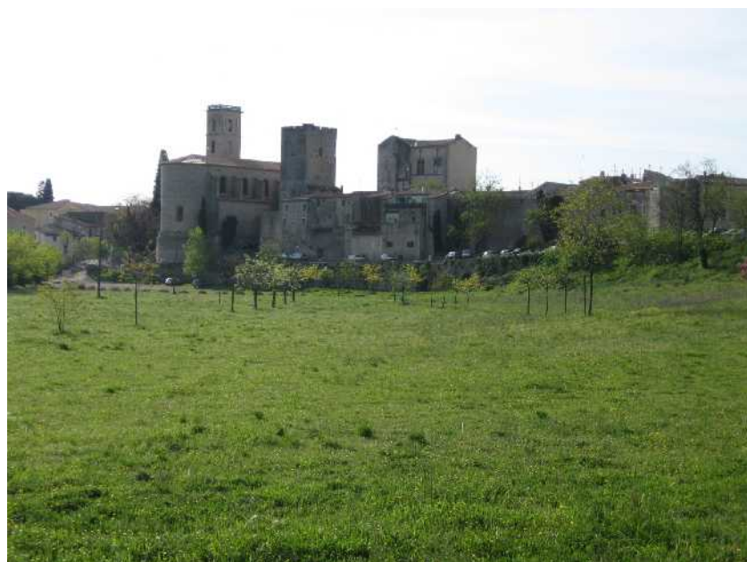
Photographie 38 : Limite de la zone inondable en rive droite à Cournonterral
