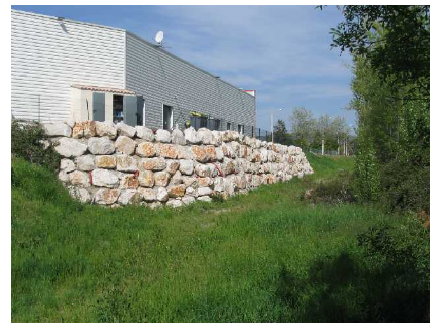
Photographie 40 : Protection de berge sur le ruisseau de la Billière
