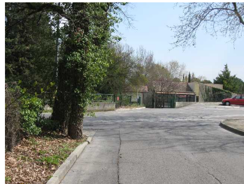
Photographie 13 : Ecole en zone inondable en rive droite
