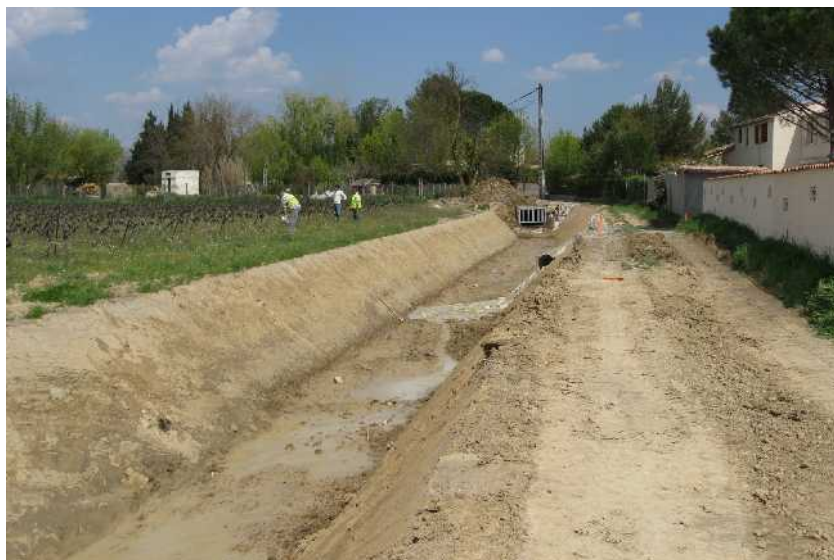
Photographie 11 : Chenalisation d'un ruisseau dans la plaine alluviale du Lez
