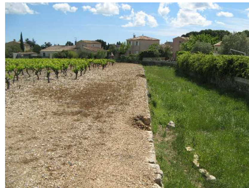
Photographie 28 : Nouvelles constructions en zone inondable
