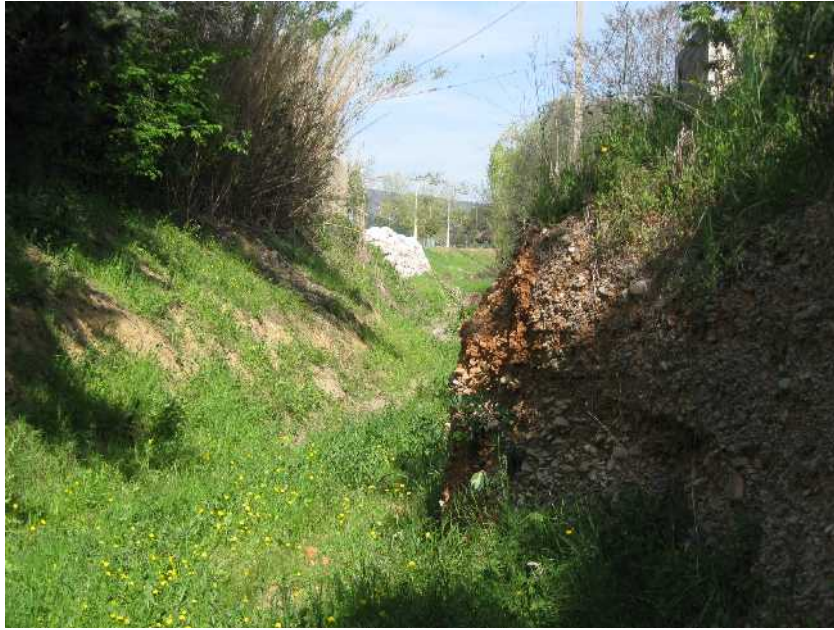
Photographie 41 : Erosion de berge sur le ruisseau de la Billière
