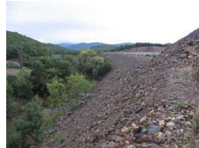
Photo 11 : Remblai du Gournautuc limitant les débordements
