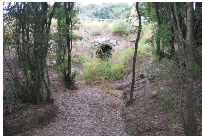
Photos 1 – 1bis : Busage du Libron dès sa partie amont (amont/aval)
