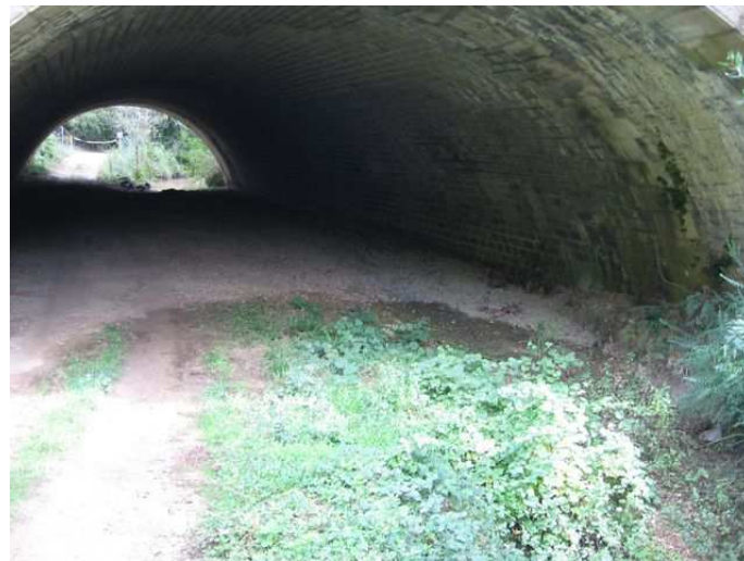
Photo 13 : Ouvrage hydraulique de la voie ferrée – section fortement réduite.
