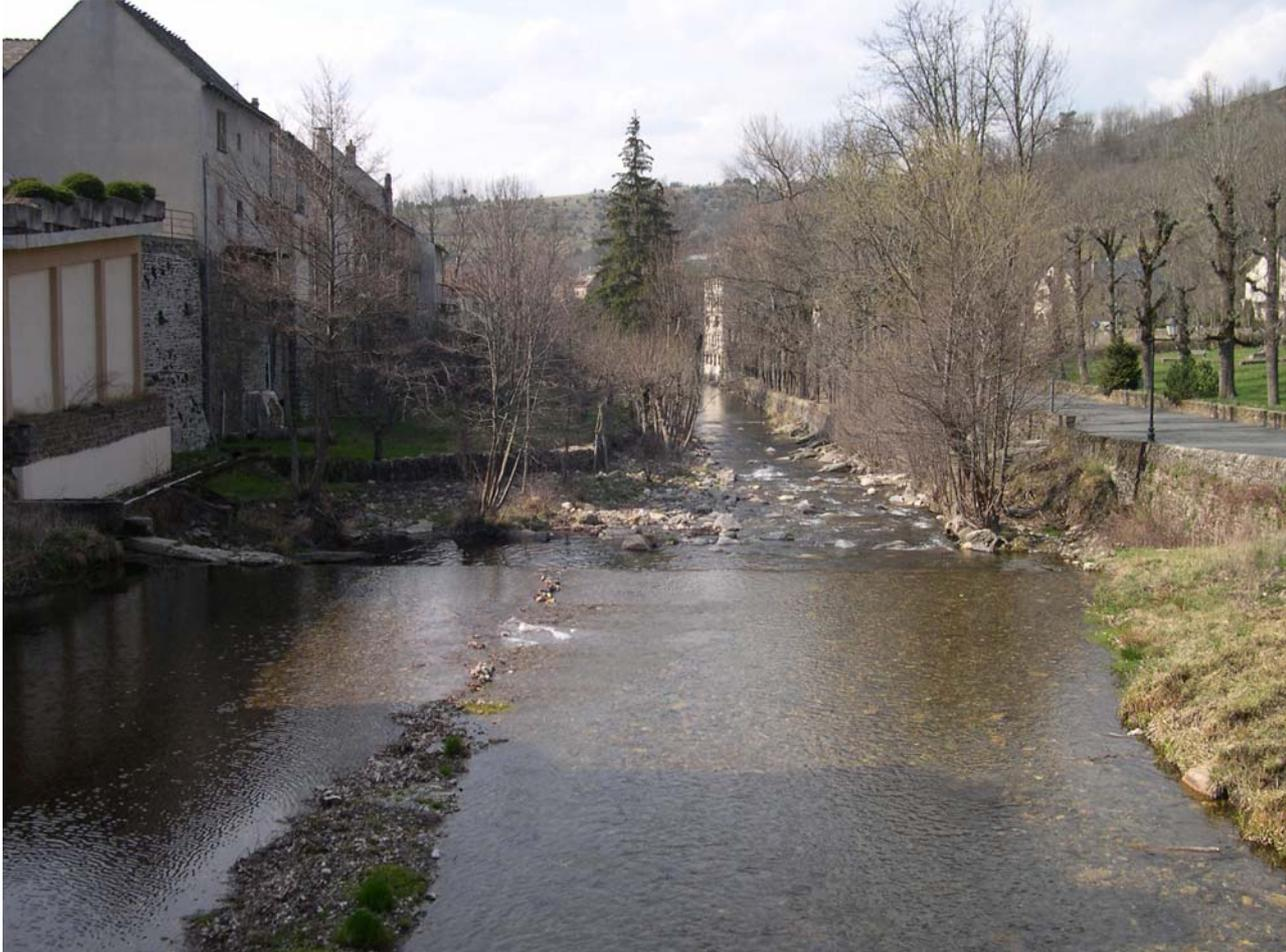
**photo 6 : le seuil de l'entrée de Bagnols apparaît au premier plan. Il casse l'énergie du Lot. A partir de ce point, le cours d'eau est canalisé. En rive droite, le lit majeur s'étend jusqu'à la route RD 901 et recouvre le parc. En rive gauche, la façade des maisons s'impose aux crues.**
