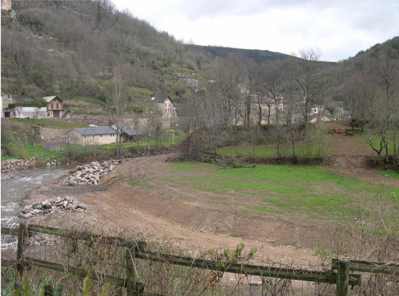
**photo 14:** en arrière plan le lit majeur s'arrête à la route qui passe au dessus du muret. Les berges de la Colagne ont été remaniées et sont protégées par des enrochements, ce qui montre bien la capacité du cours d'eau à creuser son lit.
