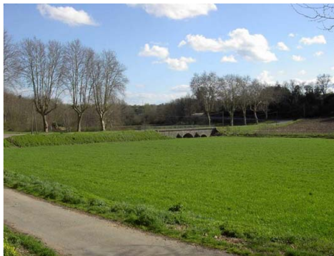
Photo 5 : Remblai barrant la plaine alluviale
