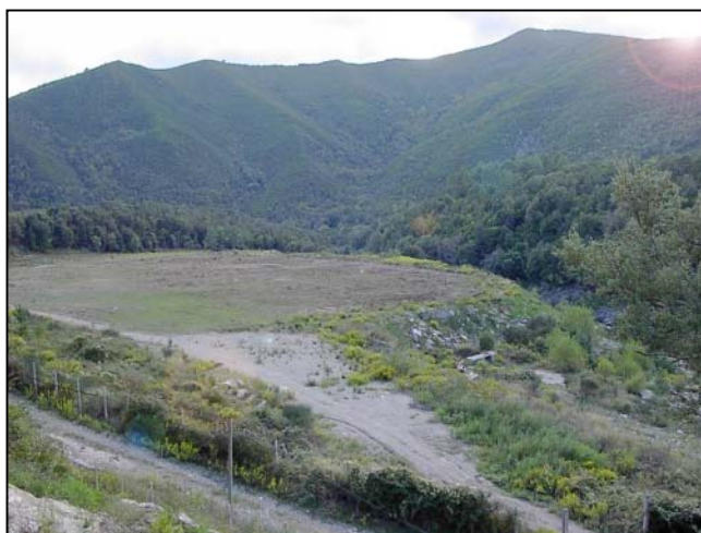
Remblais empiétant sur la plaine alluviale
