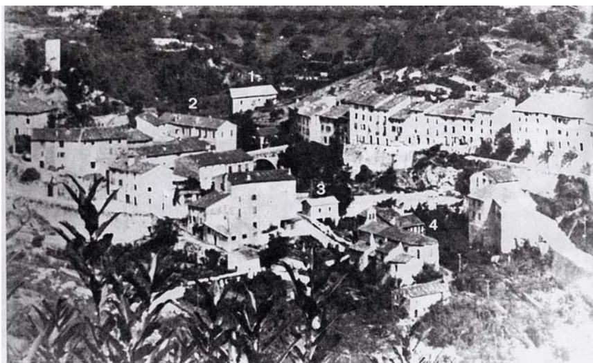
N° 61 Le village de Le Tech avant 1940. Cliché Fion. Bâtisses emportées par la crue : 1 Usine Coste Frères - 2 Immeuble mairie écoles - 3 Garage Coste - 4 Pâté de maisons comprenant l'église, le presbytère, la grande maison familiale Coste et le Moulin d'En Ribes.
