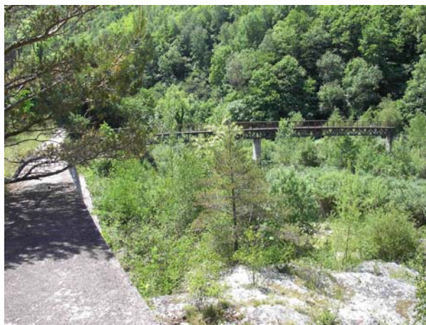
La Clapère : vue vers l'aval des 3 unités géomorphologiques et de la digue séparant lit moyen et lit majeur.
