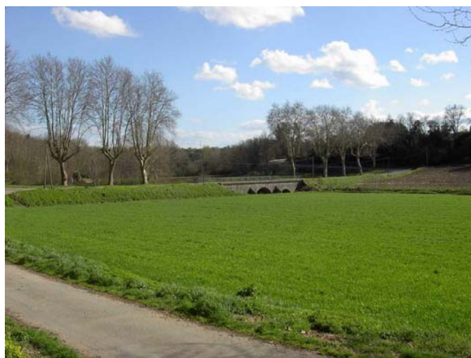
Photo 5 : Remblai barrant la plaine alluviale
