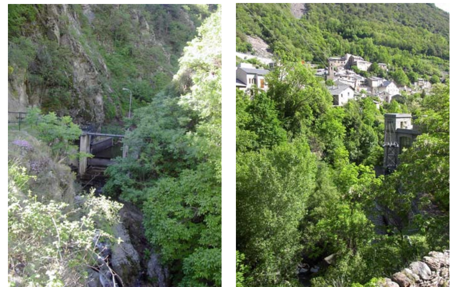
Photos n°7 et n°8, Gorges de Fontpédrouse et retenue hydroélectrique
